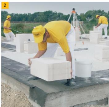
2. Первым закладывается блок в самом высоком углу здания, уровень которого определяется с помощью нивелира. Разница по высоте отдельных углов дома не должна превышать 30 мм.
