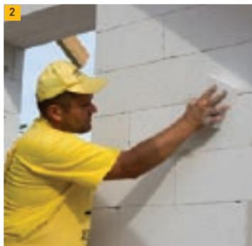
2. Избыток раствора удаляем после его затвердения при помощи куска блока YTONG®.
