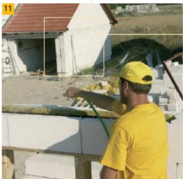
11. Перед началом бетонирования смачиваем водой U-перемычку.
