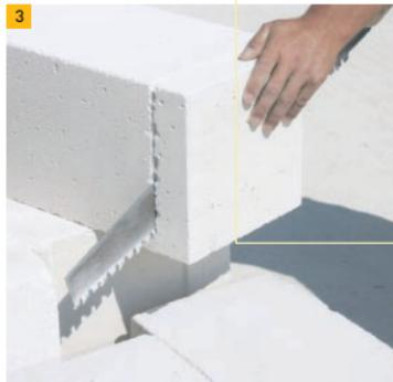
3. Чтобы распил получился более точным, необходимо отметить карандашом линию резки на двух сторонах блока – горизонтальной и вертикальной.
