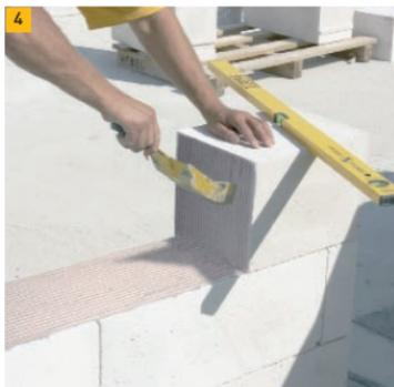
4. Раствор также наносится на вертикальную поверхность блока посредством прижатия кельмы к нижней части вертикальной стенки блока и перемещением её вверх, не отрывая.
