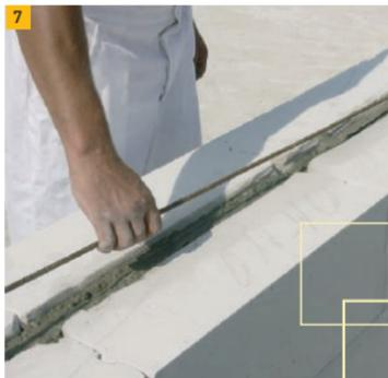
7. Вкладываем в паз стальной стержень (арматуру), лучше всего — из профилированной стали диаметром не менее 6 мм.
