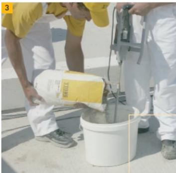
3. Добавляем сухую растворную смесь YTONG® и размешиваем до однородной массы.
