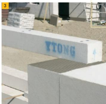
3. Минимальная глубина опирания составляет 250 мм. Перемычка укладывается так, чтобы напечатанная на ней стрелка указывала вверх.
