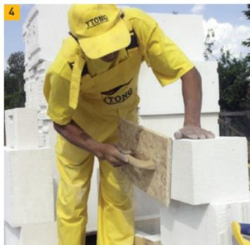
4. Чтобы получить гладкую поверхность и обеспечить хорошее сцепление раствора с блоком, поверхность блока выравняем рубанком или шлифовальной доской.
