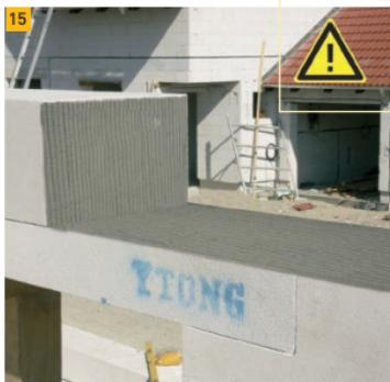
15. Блоки укладываются на перемычку на раствор YUTONG® для тонкошовной кладки. Вертикальные стыки при этом также осуществляются с применением тонкошовного раствора (вне зависимости от наличия системы «паз-гребень»).
