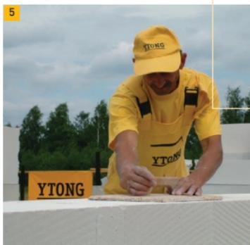
5. Имеющиеся неровности кладки устраняем при помощи шлифовальной доски или рубанка. Мелкие загрязнения и пыль удаляем щеткой.
