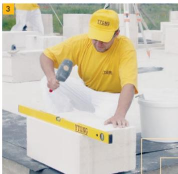
3. Горизонтальное и вертикальное положение блоков контролируется с помощью уровня и при необходимости корректируется резиновым молотком.
