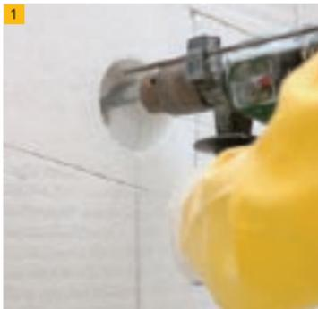
1. Отверстия для электрических розеток и выключателей высверливаются при помощи безударной низкооборотной дрели с нужной насадкой.
