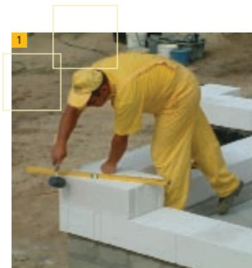
1. Кладку несущих стен начинаем с закладки угловых блоков. Каждый уложенный блок требует выравнивания не только по горизонтали, но и по вертикали.
