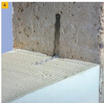
4. Соединение стены, заполняющей каркас, с железобетонной колонной или перпендикулярной железобетонной стеной выполняется при помощи металлических связей, располагаемых через каждые 2-3 слоя блоков YTONG®. При этом одна часть связи помещается в шве кладки из блоков и крепится специальными гвоздями, а вторая часть крепится к боковой поверхности столба или стены.
