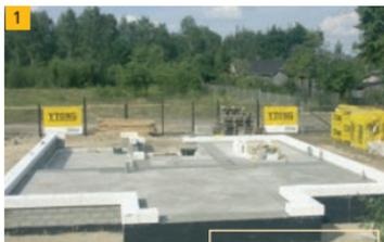
1. Кладка первого ряда стен начинается с закладывания блока в каждом углу здания. Блоки первого ряда кладутся на цементно-песчаный раствор толщиной не менее 20 мм по всей поверхности блока, при этом она может изменяться в зависимости от неровности фундамента.
