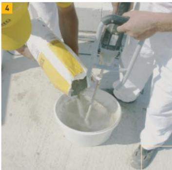
4. Рекомендуется затворить водой сразу весь мешок раствора. Этого количества готовой смеси хватает для возведения приблизительно 1,5 м<sup>3</sup> кладки газобетонных блоков.
