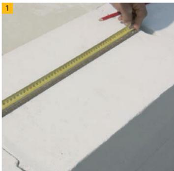
1. Если ширина оконного проема более 1,80 м, то под предполагаемым окном в предпоследнем ряду блоков следует монтировать горизонтальную арматуру. Обозначаем на поверхности блоков планируемую длину оконных проёмов. Длина арматуры должна быть длиннее оконного проёма не менее чем на 0,5 м с каждой стороны.
