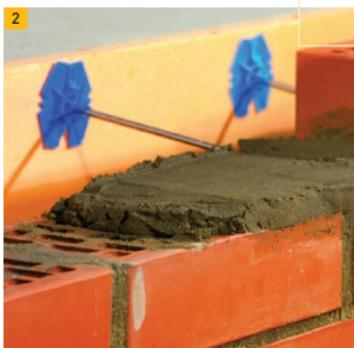
2. Крепление ограждающей кирпичной кладки к стене из газобетонных блоков YTONG® осуществляется при помощи специальных анкеров с передвижными влагозащитными шайбами.
