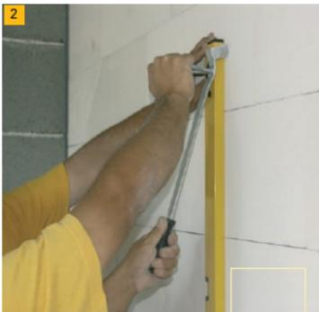
2. Наносим на стену линии прокладки внутренней проводки и коммуникаций. Для получения прямолинейных пазов прибываем к стене направляющую доску. Пазы удобнее всего сделать с помощью ручного штробореза YTONG®, который направляется вдоль доски YTONG®.
