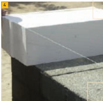
4. Между установленными угловыми блоками растягиваем шнур-причалку и заполняем ряд. Если расстояние между углами превышает 10 метров, то между угловыми блоками устанавливается дополнительный блок, за который закрепляется шнур. Данная мера предотвратит его провисание. Заполняем первый ряд.
