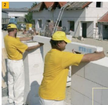
2. Для наружной стены толщиной 50 см можно использовать две перемычки шириной 175 мм и перемычку с шириной 150 мм. (Альтернативно — четыре перемычки с шириной 125 мм)
