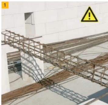
1. U-образные блоки YTONG® являются элементами опалубки для железобетона. Железобетонная часть должна иметь соответствующее проведенным расчетам армирование. Для армирования лучше всего подходит пространственный арматурный каркас.
