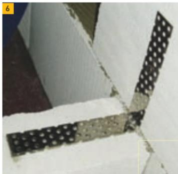
6. Анкеровка дополнительно возводимой перегородки. Гибкие связи крепятся к несущей кладке дюбелем. Для крепления перегородок к перекрытиям используются гибкие связи кладки или монтажная пена.
