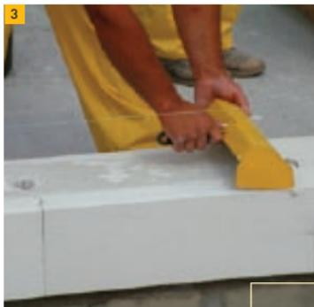
3. Наносим раствор YTONG® для тонкошовной кладки на горизонтальную поверхность блока с помощью кельмы YTONG® соответствующей ширины, затем, перевернув кельму, равномерно распределяем по всей поверхности блока.
